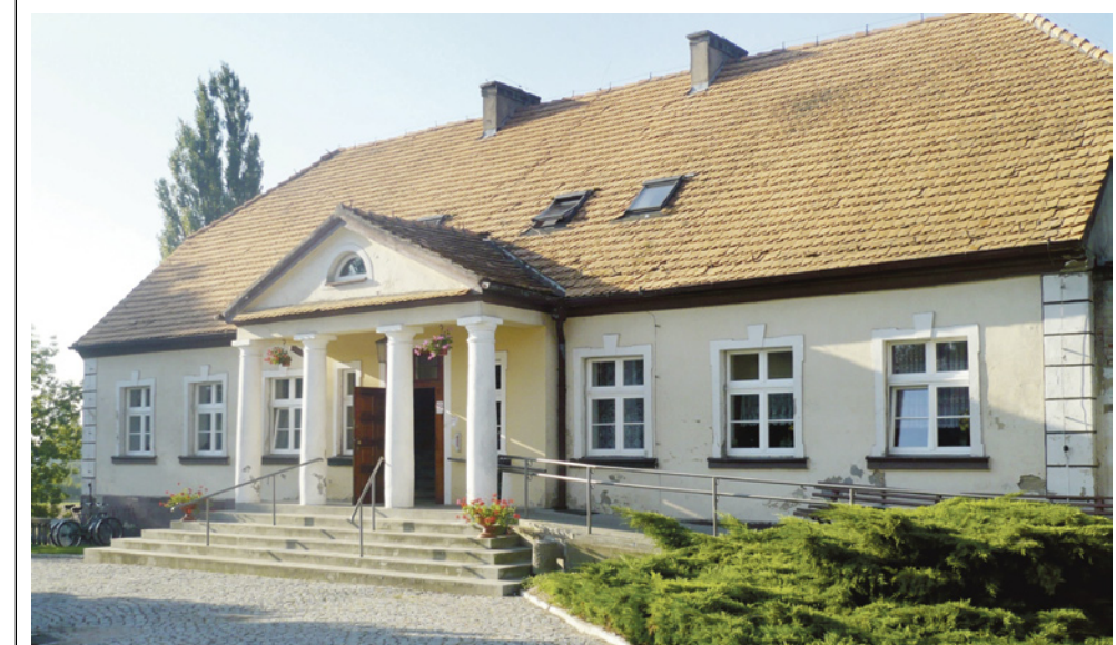
Zabytkowy budynek Domu Pomocy Społecznej w Srebrnej Górze ma już nowe okna.
