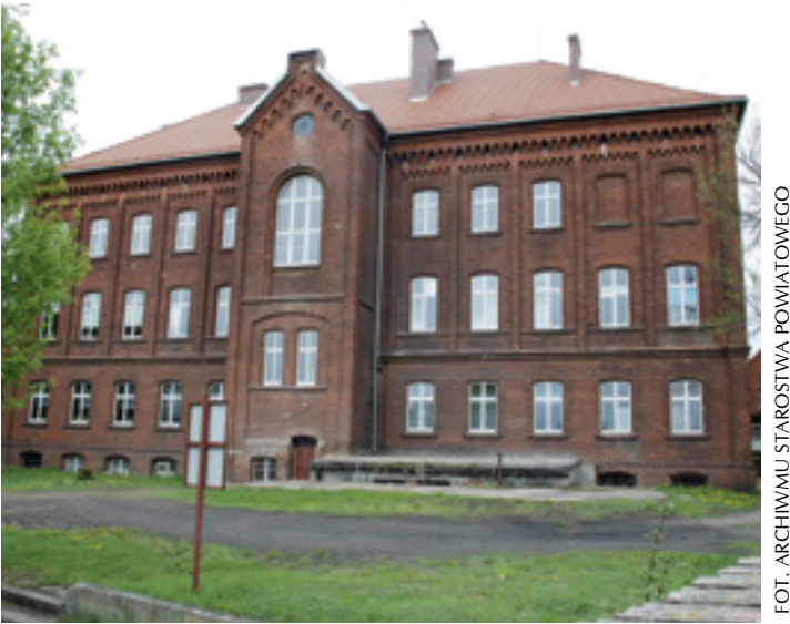
W ubiegłym roku przebudowano dach na budynku I LO w Wągrowcu oraz dokonano remontu poddasza.
