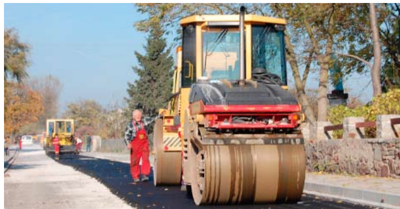
Remont drogi w Żabiczynie
