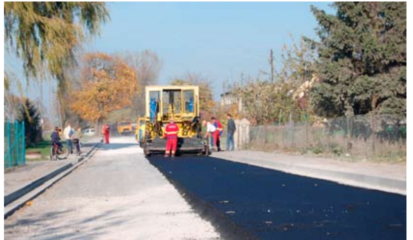
Remont drogi w Żabiczynie.
