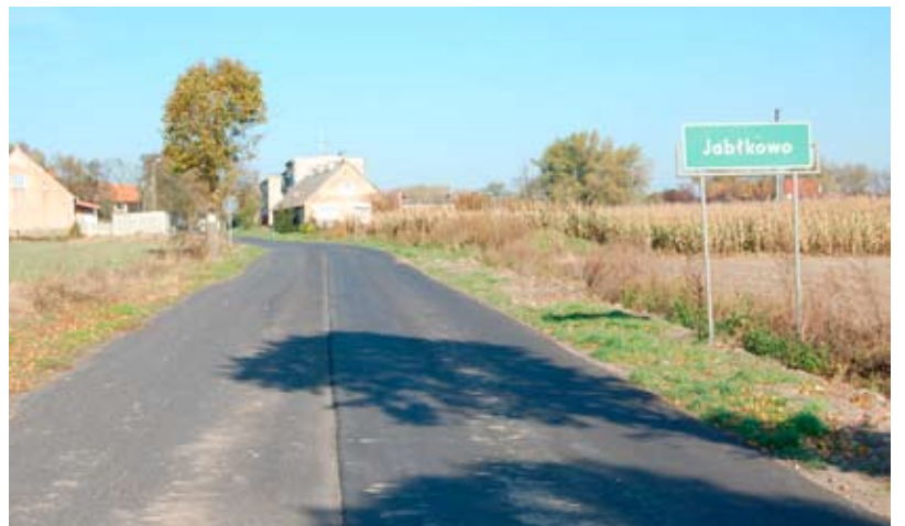
Na drodze Jabłkowo - Nowiny zostanie położona nowa warstwa ścieralna.
