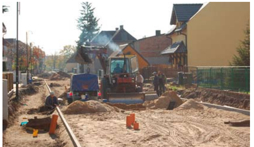
Trwa przebudowa ulicy Średniej w Wągrowcu.
