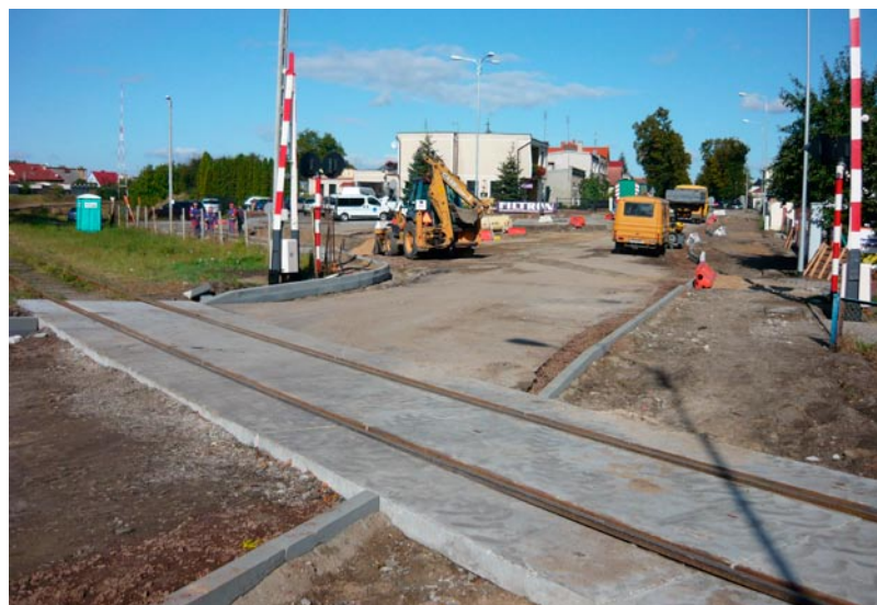
Przebudowa przejazdu kolejowego na ul. Bartodziejskiej.
