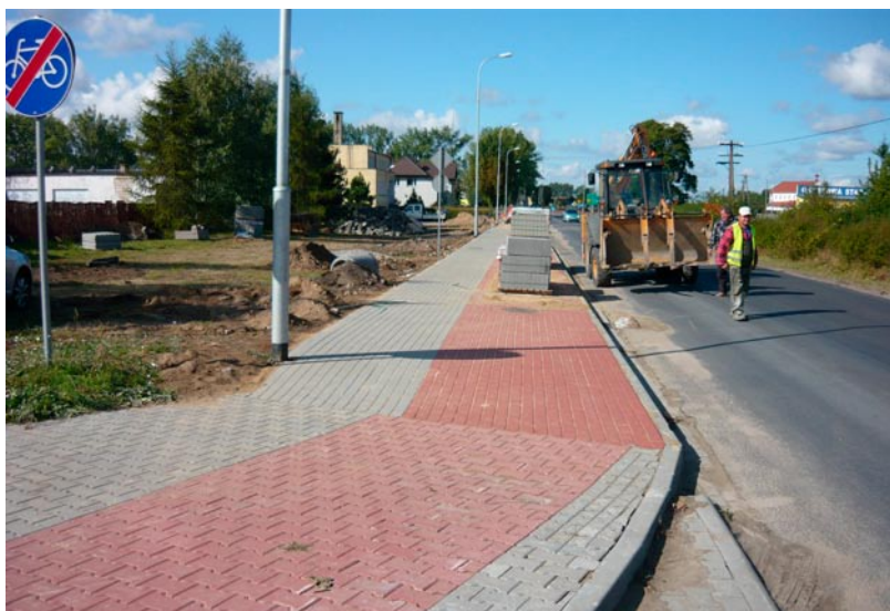
Trwa budowa chodnika przy ul. Janowieckiej w Wągrowcu.
