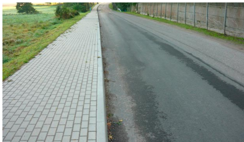
W Żelicach przeprowadzono remont drogi na odcinku 240 m.
