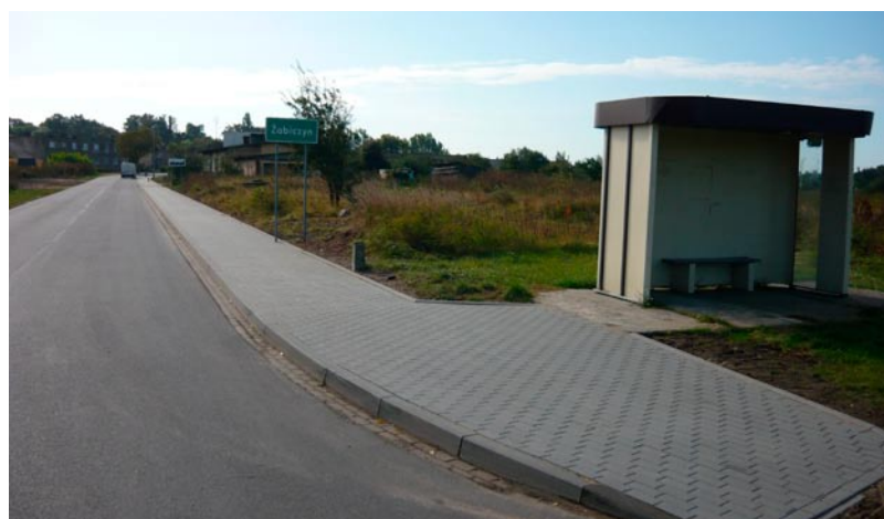
Wykonano już chodnik w Żabicy.
