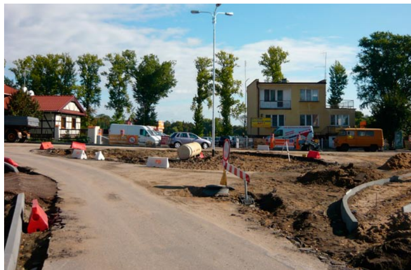
Budowa ronda na ul. Bartodziejskiej w Wągrowcu.
