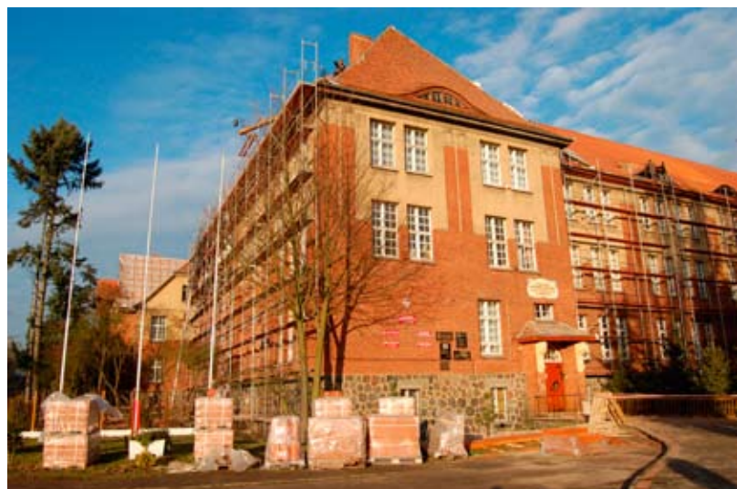
Remont dachu na Zespole Szkół Ponadgimnazjalnych nr 2 w Wągrowcu.
